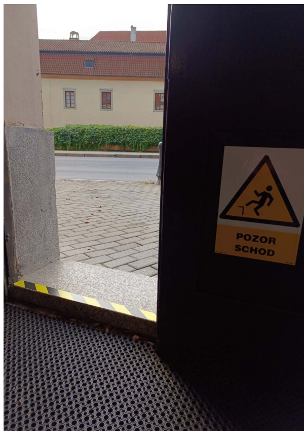
Obr. 18 Označení vyvýšených míst
