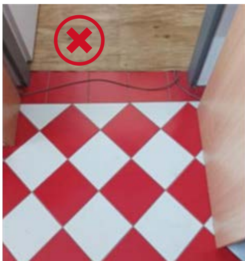
Obr. 5 Kabely volně ložené přes cestu
