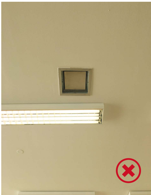
Obr. 8 Zakrytí výdechu ventilace
