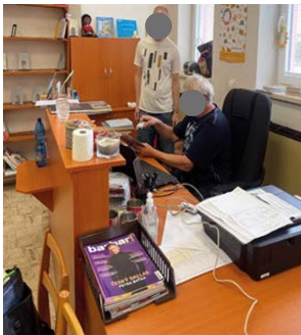
Obr. 7 Nevhodné vedení kabelů
